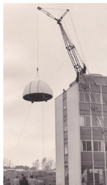
Manceuvre délicate , la mise en place de la coupole.
